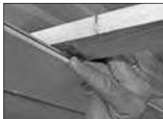
Colocación de la grapa de fijación
