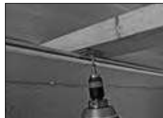
Atornillado de la grapa de fijación
