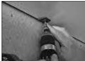
Montaje del clip para listones
