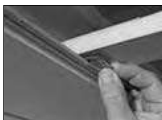
Colocación de la grapa de fijación
