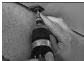
Montaje del clip para listones
