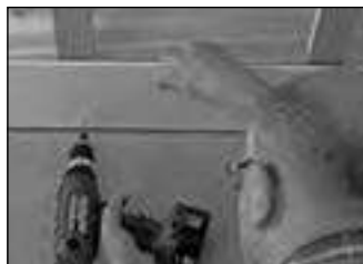
Sujeción del primer panel machihembrado
