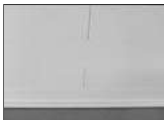
Colocación de cornisas: listo
