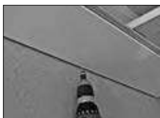
Sujeción del primer panel machihembrado
