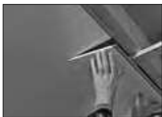
Encaje de los paneles con sistema de clic
