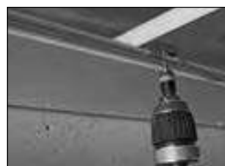
Atornillado de la grapa de fijación
