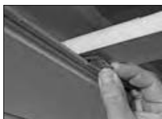
Colocación de la grapa de fijación
