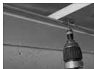
Atornillado de la grapa de fijación
