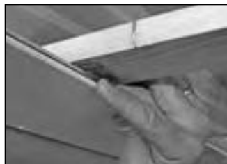
Colocación de la grapa de fijación
