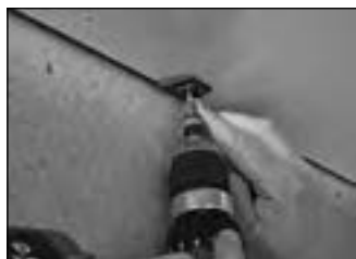
Montaje del clip para listones
