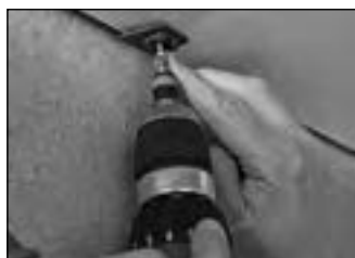
Montaje del clip para listones
