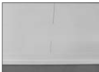
Colocación de cornisas: listo
