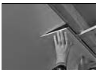
Encaje de los paneles con sistema de clic
