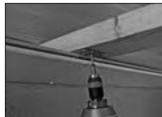
Atornillado de la grapa de fijación
