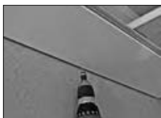
Sujeción del primer panel machihembrado
