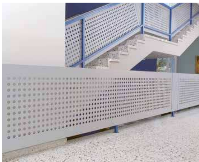
BARANDILLA DE LA ESCALERA - FRESADO DEL AGUJERO
