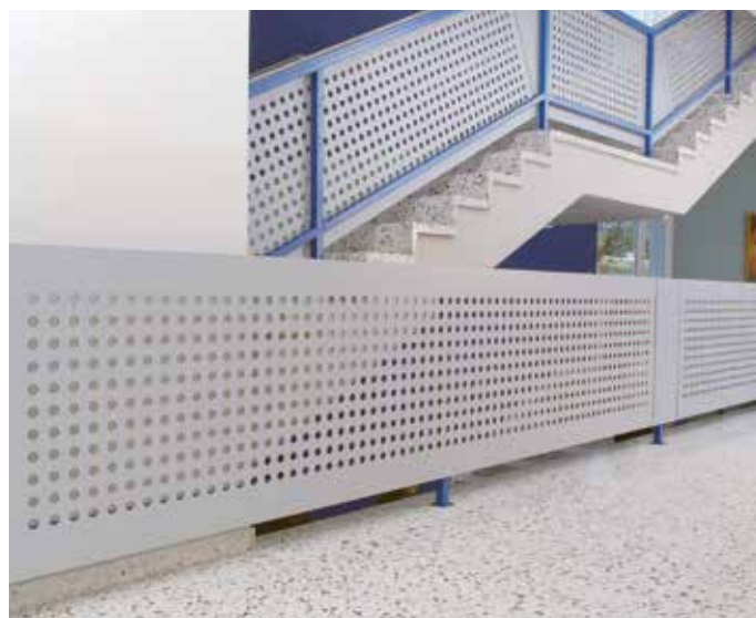
BARANDILLA DE LA ESCALERA - FRESADO DEL AGUJERO
