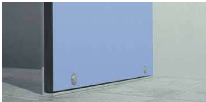
CONEXIÓN AL SUELO CON PERFIL L
